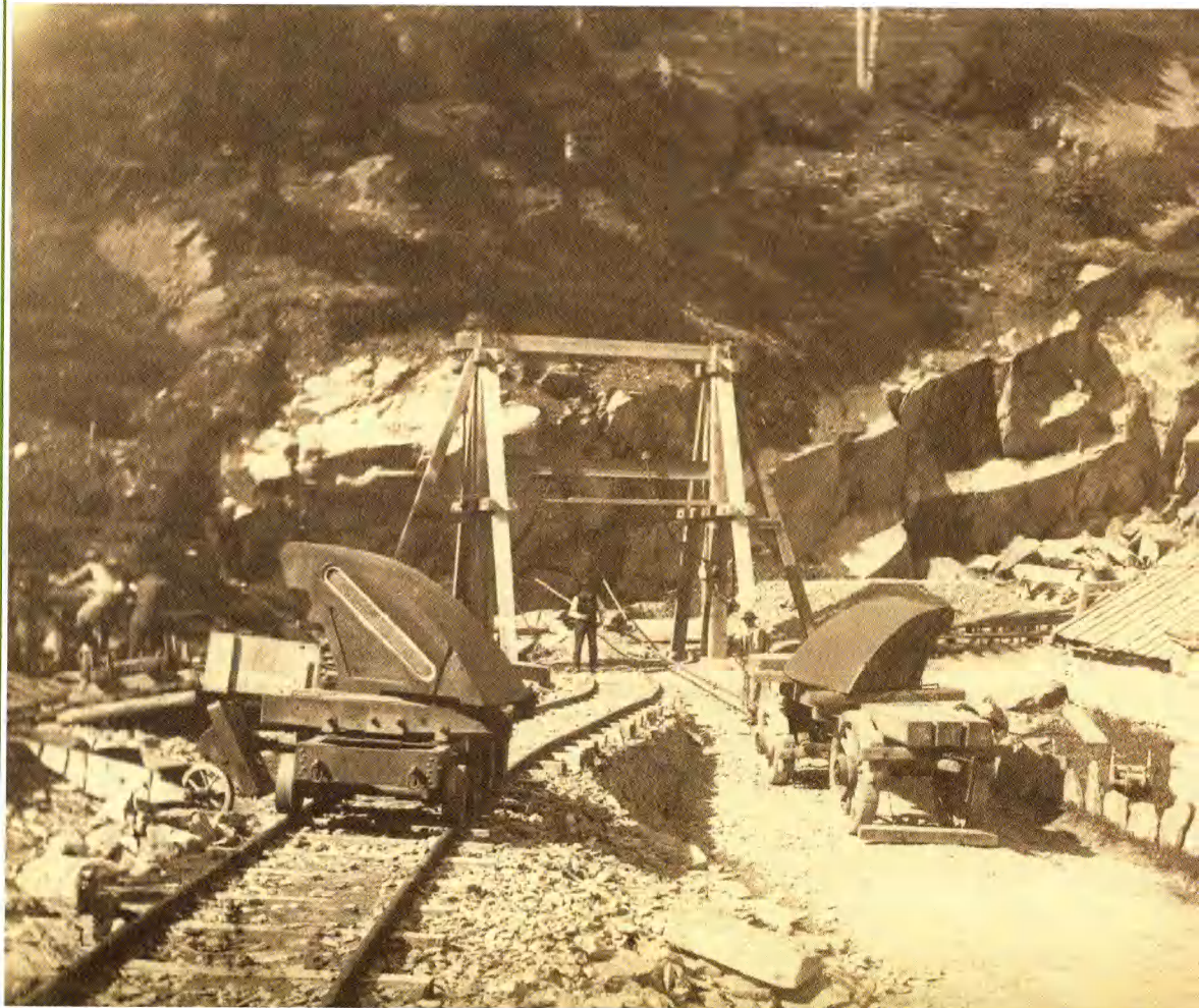
Airolo – Portique de transbordement des cuirassements
